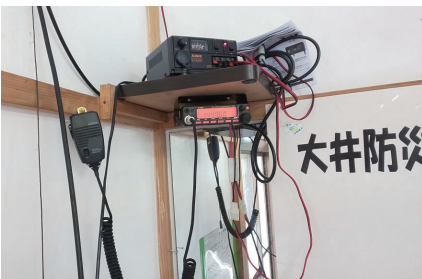
▲地区で整備した防災無線
